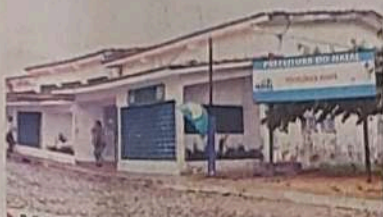
Policlínica da Zona Norte: problemas nas instalações elétricas
