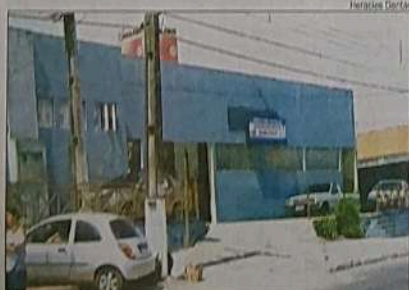
Com transferência do serviço, obras no posto já podem começar
