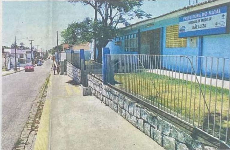
Em Mãe Luiza, a interdição do Pronto-Atendimento da Unidade de Saúde foi ocasionada pela falta de escada de plantão
