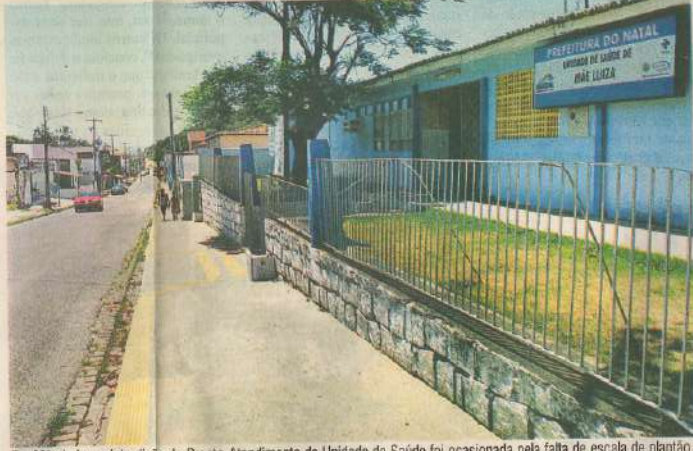
Em Mãe Luiza, a interdição do Pronto-Atendimento da Unidade de Saúde foi ocasionada pela falta de escada de plantão.
